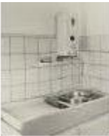
Der alte Abwaschsteintrog mit Gas-Durchlauferhitzer
